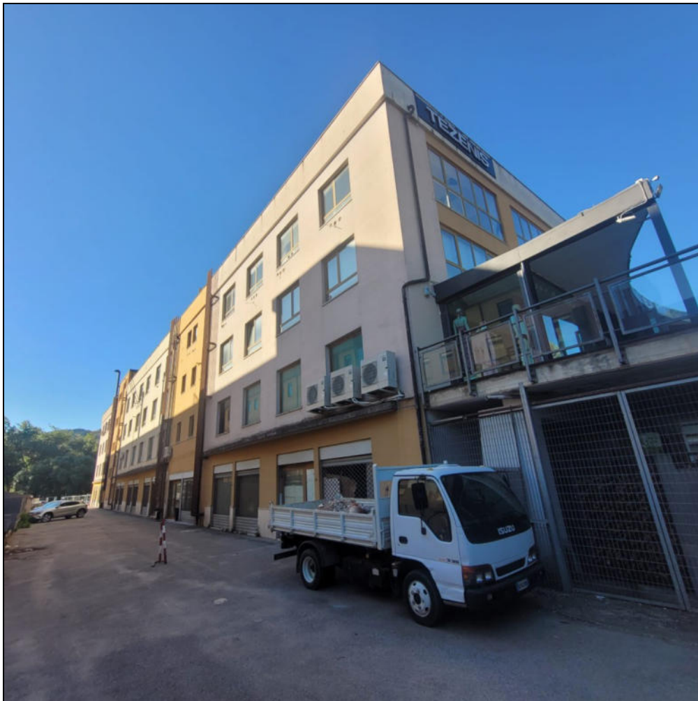
Vista del prospetto laterale del fabbricato
